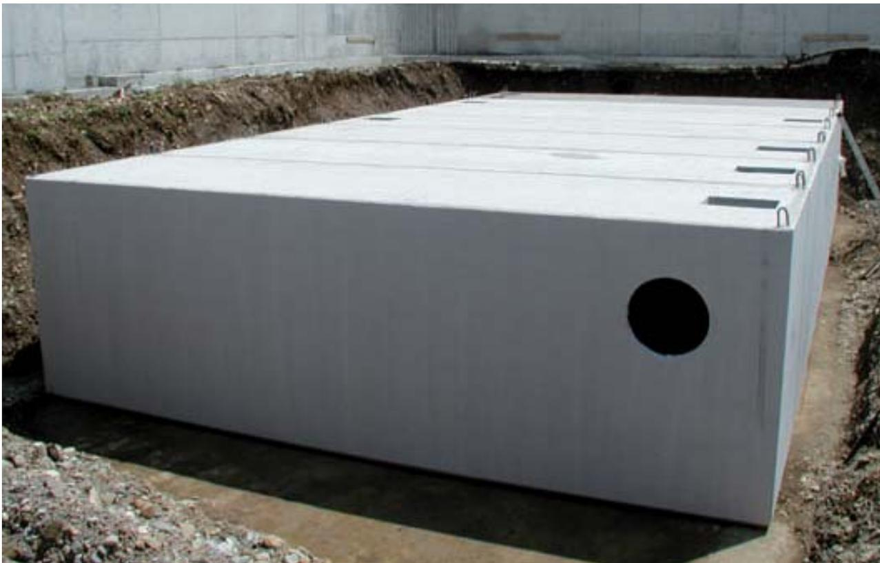
Vasca di stoccaggio con disoleatore separato serie VPD09
