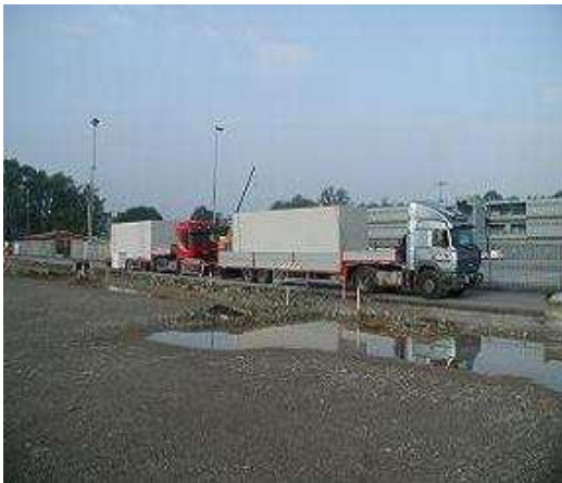
Trattamento acque di prima pioggia
