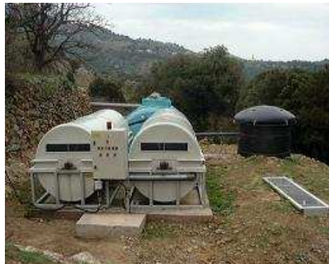
Impianto a biodischi
